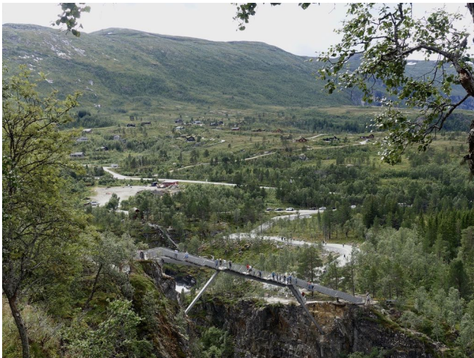
Links die neue Brücke über den Fluss.
